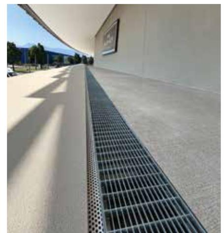
Die Entwässerung sollte als durchgängige Linie harmonisch in das gestalterische Gesamtkonzept integriert werden. Technisch umsetzbar war dies nur durch die Sonderanfertigung der notwendigen Revisionskästen durch BG-Graspointner. © BG-Graspointner
