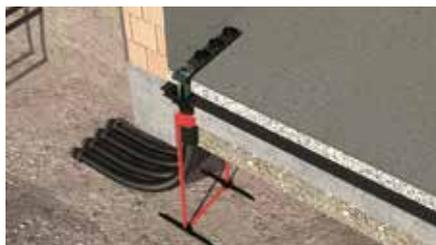
Für den Fußbodenaufbau muss nur noch der Estrichaufsatz aus der BOX gezogen werden und mit der Höhenfixierung auf die gewünschte Höhe gebracht werden
