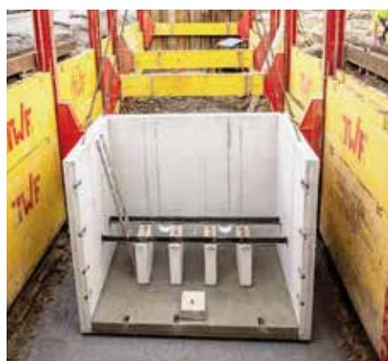
Werkseitig montierte Betonsockel dienen als Pumpenfundamente
