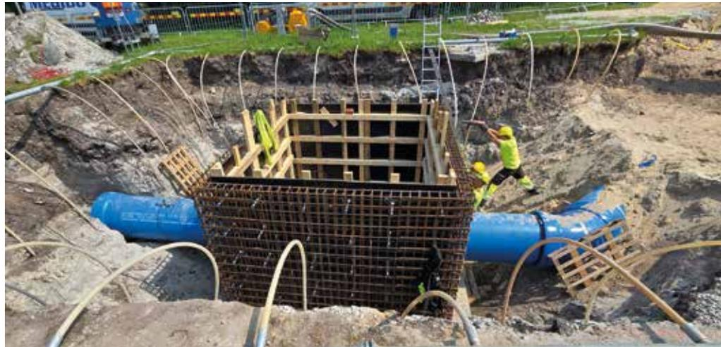
Schieberschacht mit Absperrklappe DN 800, Pass- und Ausbaustück und T-Stück DN 800/200
