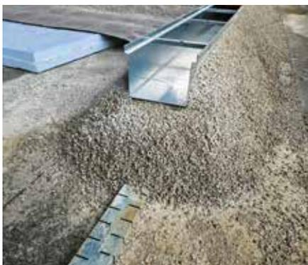
Entwässert wird über zwei Ebenen: Unten sitzt der Stichkanal für das Sickerwasser. In dem darüberliegenden Drainagebeton wurde die BG-FLEX FA eingebettet. Sie leitet das Oberflächenwasser sicher zu den Dacheinläufen. ©BG-Graspointner
